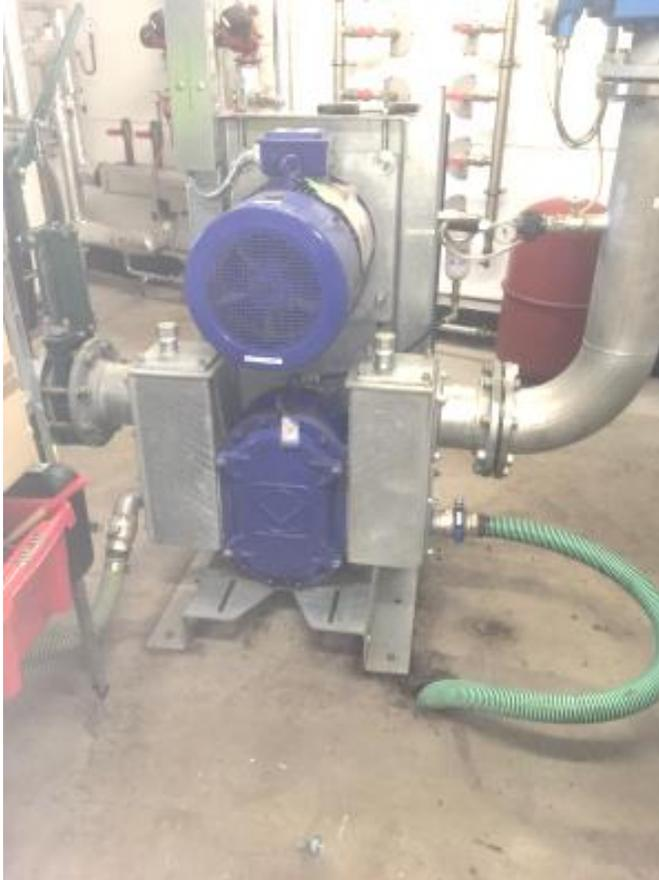
Substratpumpe: Diese Pumpe ist eine Drehkolbenpumpe. Sie saugt das Substrat über eine Saugleitung am Pumpenbalken an und fördert es über die Druckleitung am Pumpenbalken weiter.
