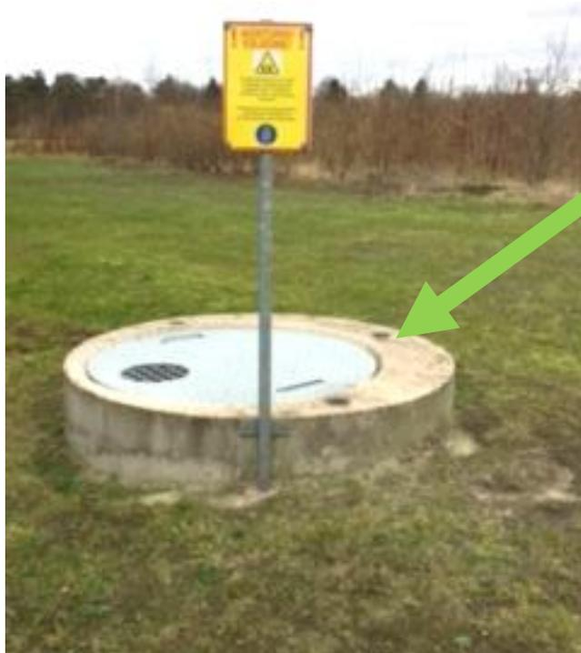
Während das Biogas aus dem Fermenter und Gärrestlager unterirdisch über ein Rohr zur Gasaufbereitung strömt, kondensiert Wasser aus dem Biogas, welches sich im Kondensatschacht sammelt. **Der Kondensatschacht fängt also das (kondensierte) Wasser aus dem Biogas auf.**
