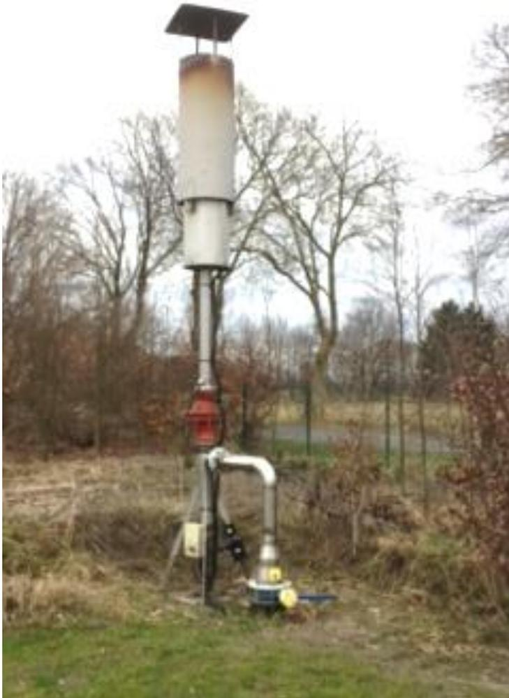
Mit der Gasfackel wird nicht genutztes oder überschüssiges Biogas zu Kohlendioxid und Wasserdampf verbrannt. Die Umweltbelastung bei der Verbrennung ist geringer als beim Abblasen überschüssigen Biogases in die Umwelt. Das bei der Verbrennung entstehende Kohlendioxid ist zwar ebenfalls ein Treibhausgas, der Treibhauseffekt des Methan im Biogas ist aber 25-mal stärker.
