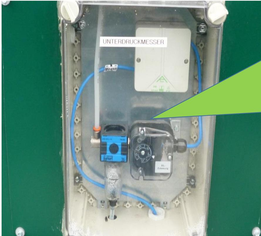
Druckschalter Unterdrucksicherung, der Druckschalter springt bei Versagen der Über-/Unterdrucksicherung automatisch an, so kann bei unzulässig niedrigen Drücken kein Biogas mehr dem Behälter entnommen werden.
