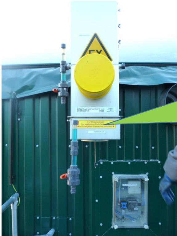
Über-/Unterdrucksicherung, sie schützt den Behälter selbsttätig vor unzulässigen Gasdrücken im Inneren des Behälters. Sie verhindert, dass ein Vakuum unter der Gasfolie entsteht oder dass zu viel Biogas unter der Gasfolie vorhanden ist.
