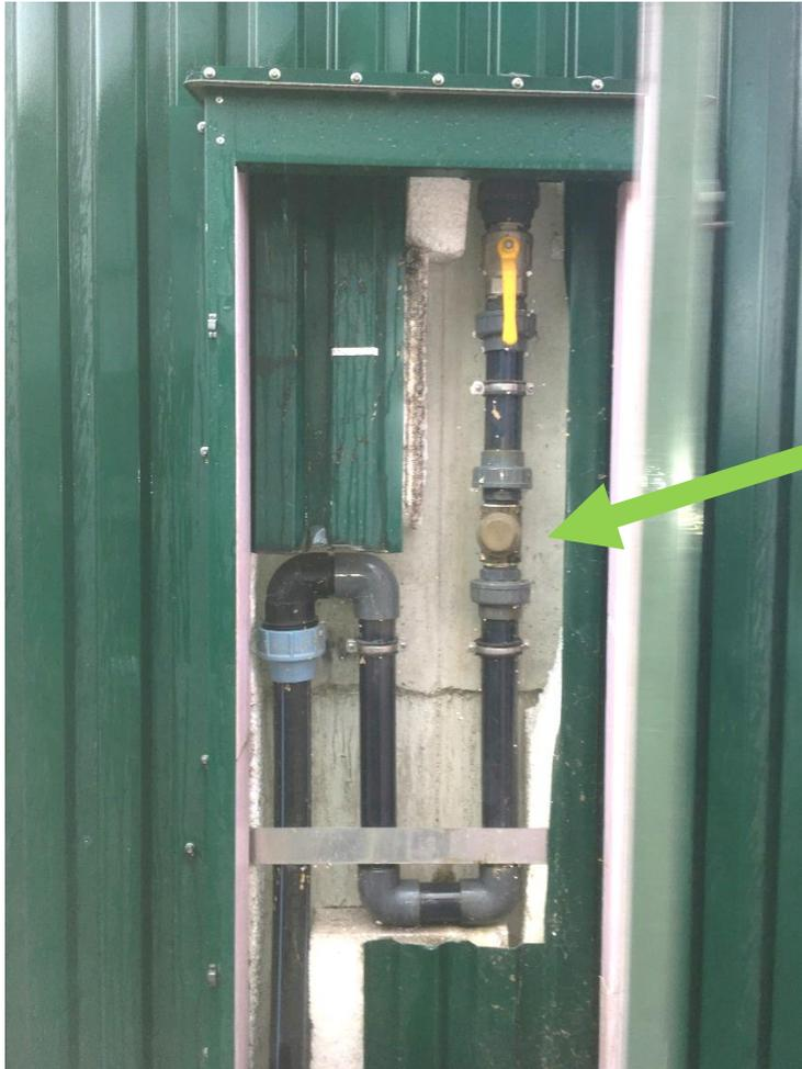
Aus dem Silo tritt Sickersaft heraus. Der Sickersaft wird unterirdisch im Sickersaftschacht aufgefangen und mittels Pumpe über eine Rohrleitung ins Gärrestlager gepumpt.
