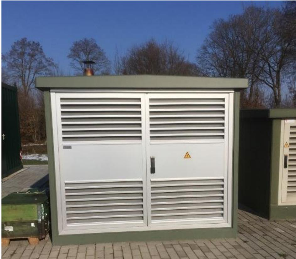
Die Trafostation ist ein Bauelement der Elektrotechnik. Die Trafostation nennt man auch Umspanner oder Transformator, oder kurz **Trafo**. Transformatoren verbinden verschiedene Spannungsebenen des Stromnetzes miteinander.
