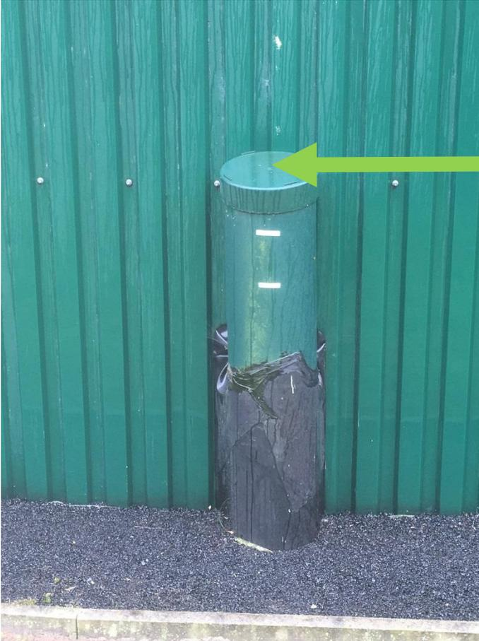
Durch Anheben des Deckels schaut man ins Innere des Kontrollschachtes Leckage. Im Kontrollschacht wird angezeigt, ob der Behälter Undichtigkeiten aufweist. Sammelt sich also im Inneren des Schachtes Flüssigkeit an, so werden Undichtigkeiten nachgewiesen.
